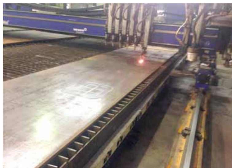
21 декабря 2015 г.: Резка первых плит конструкционной стали для модулей в Роверето, Италия.
