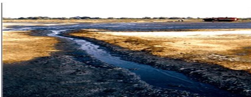
Система дренажа для предотвращения попадания вытекающей из скважин жидкости с высоким содержанием нефти на ландшафт и в водные объекты.
